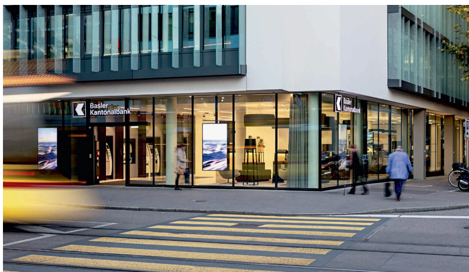
Die Basler Kantonalbank konnte ihren Wärme- sowie Strombedarf durch die Gesamtsanierung ihres Hauptsitzes markant reduzieren.
